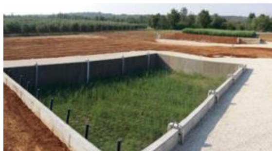
Trstične grede za osuševanje in mineralizacijo komunalnega blata
