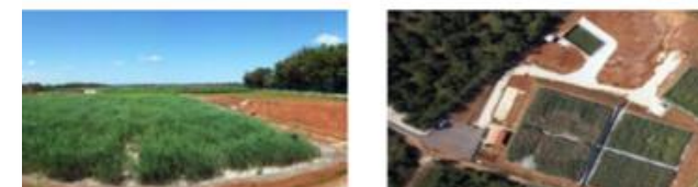
Rastlinska čistilna naprava za odpadne vode
