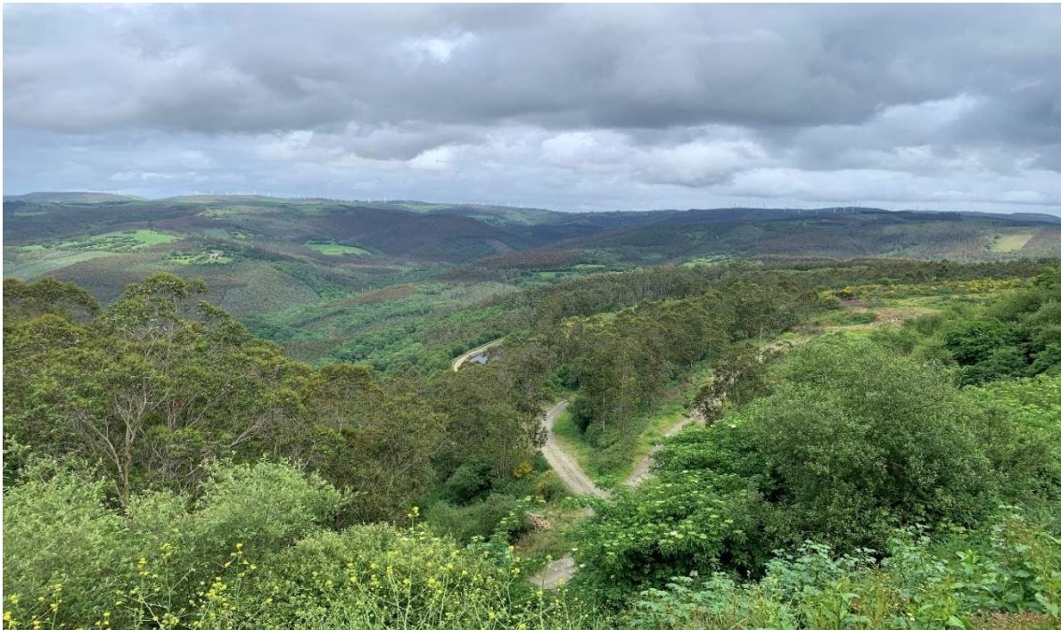
4. Vertedero de Xiloga en As Somozas, Galicia con las zonas húmedas de tratamiento en construcción. Crédito de la foto: Marietta Sandilands
