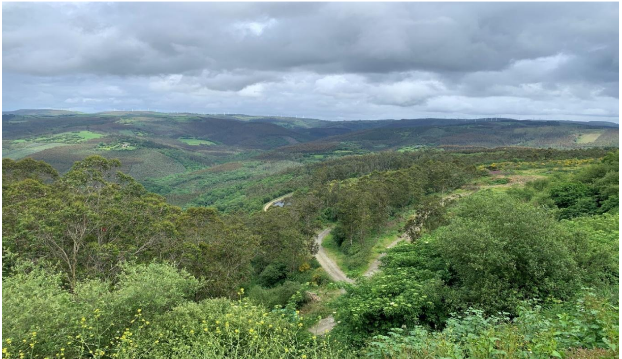
4. Vertedero de Xiloga en As Somozas, Galicia, con las zonas húmedas de tratamiento en construcción. Crédito de la foto: Marietta Sandilands
